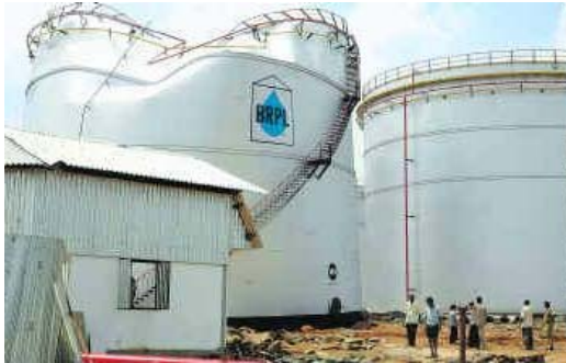
Collasso di un serbatoio della BR Petrochem durante il test di pressione con acqua
