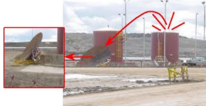
Cedimento del tetto di un serbatoio a causa del riempimento esagerato con acqua
